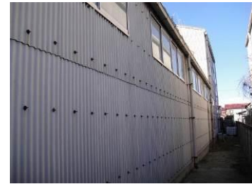
写真5 実験場所（外壁面）
